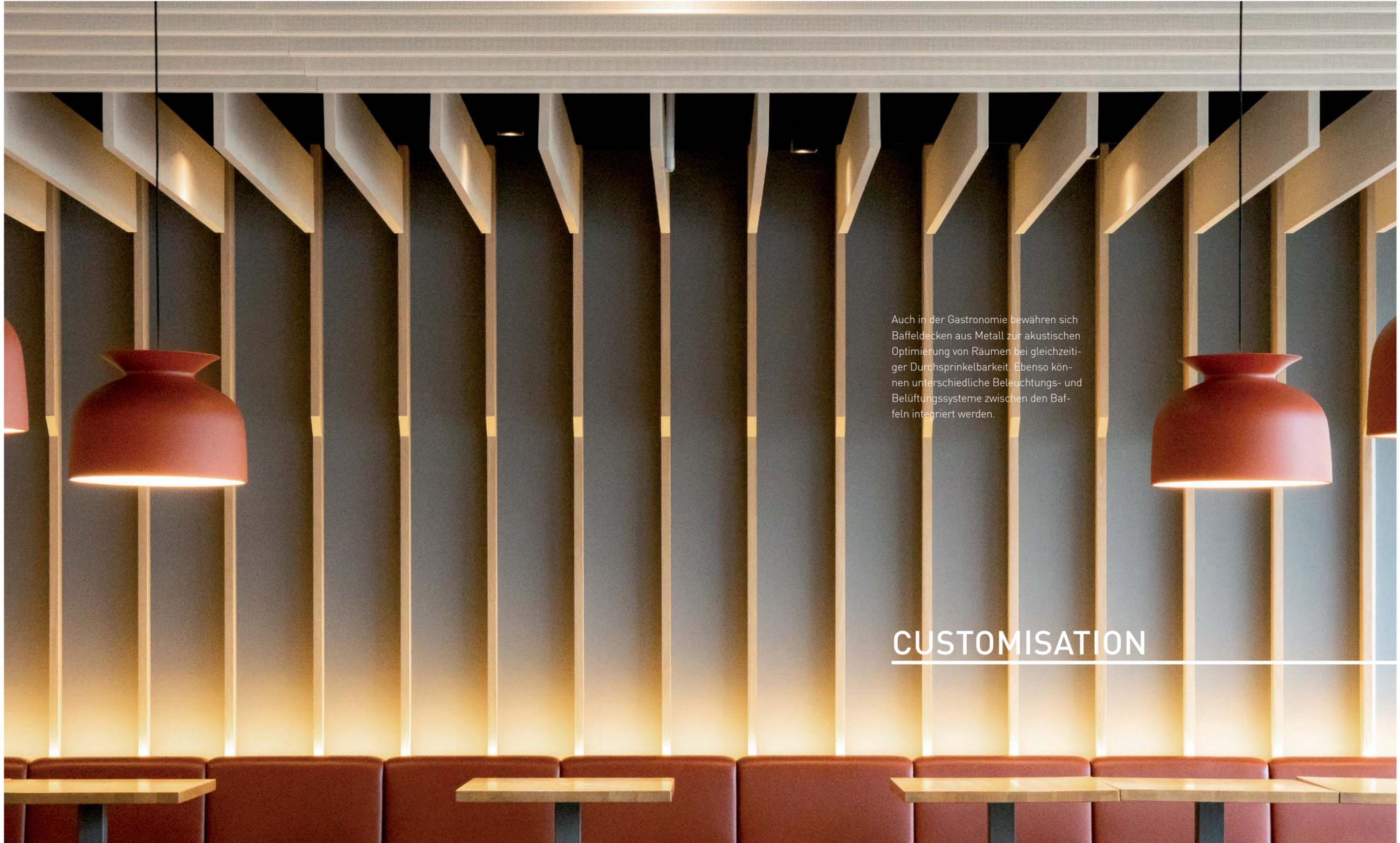
Auch in der Gastronomie bewähren sich Baffeldecken aus Metall zur akustischen Optimierung von Räumen bei gleichzeitiger Durchsprinkelbarkeit. Ebenso können unterschiedliche Beleuchtungs- und Belüftungssysteme zwischen den Baffeln integriert werden.
