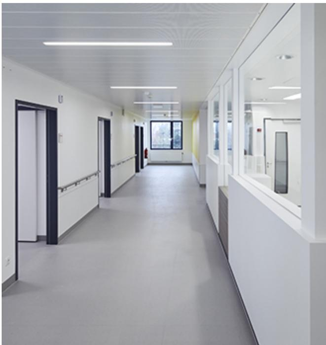
Zuwachs im Bereich Leuchten. Die Fural LED-Leuchtsenserie 481 wurde um zwei neue Leuchtentypen erweitert: **IP 54 BAT/MPS** und **IP 54 OS**. Die direkt strahlende Einbauleuchte mit Opalabdeckung mit Schutzart IP54 eignet sich hervorragend zum Einbau in Fural-Metallkassetten in sämtlichen Feuchträumen. Die IP 54 BAT/MPS sorgt für die richtige Beleuchtung bei sämtlichen Bildschirmarbeitsplätzen.
