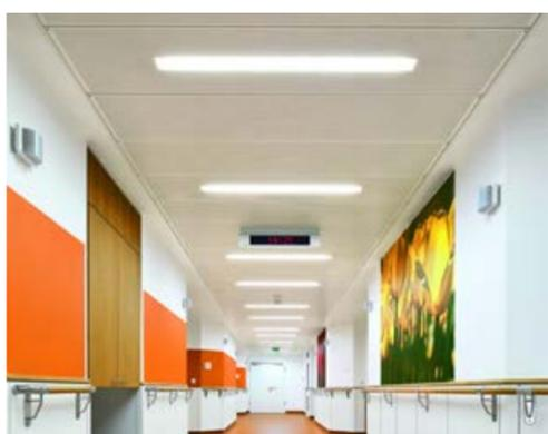
**FP-Secure** ist die erste Brandschutzdecke (F30) mit integrierter **LED-Leuchte**. Das richtungweisende System ist das Ergebnis einer gemeinsamen Entwicklung von FURAL und Philips im Rahmen des Green Hospital Programms der Asklepios-Kliniken.
