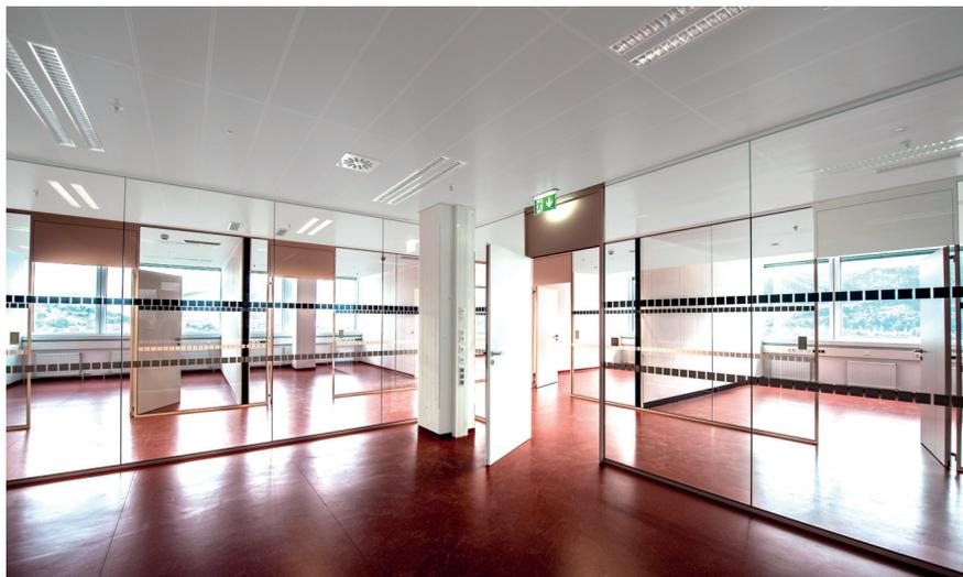
Für die neue, matte Akustikdecke Parzifal wird Hydroeinbrennlack als Beschichtungsverfahren verwendet. Die Standardoberflächen sind von Natur aus matt und verhindern die typischen unbeliebten optischen Streiflichteffekte.
