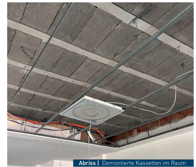
Abriss | Demontierte Kassetten im Raum
