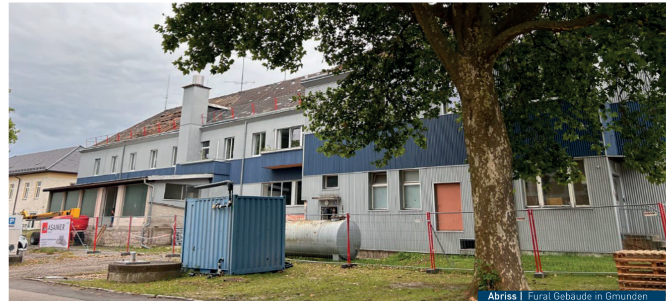
Abriss | Fural Gebäude in Gmunden
