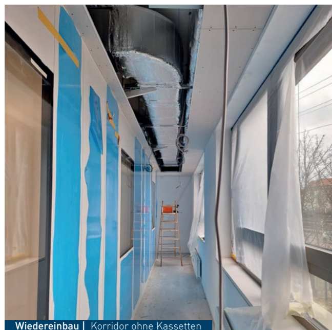
Wiedereinbau | Korridor ohne Kassetten
