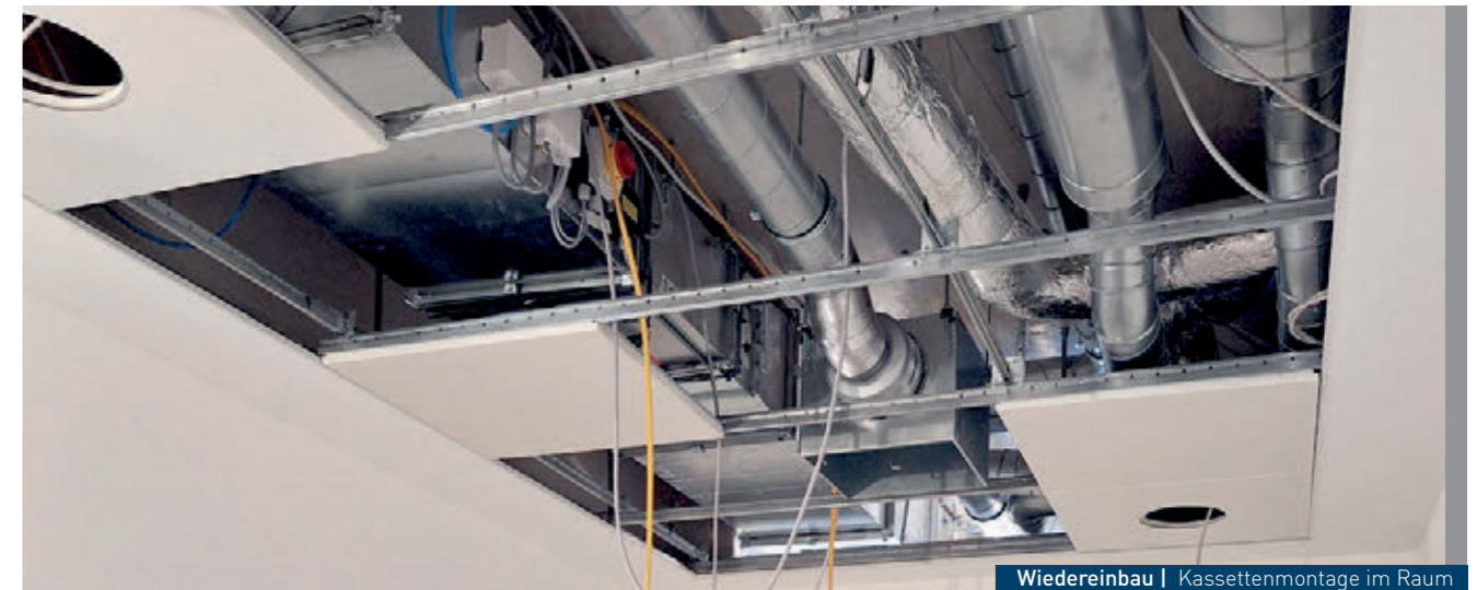
Wiedereinbau | Kassettenmontage im Raum
