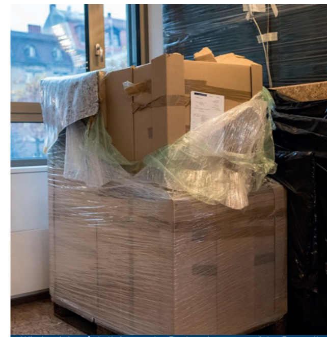
Wiedereinbau | Anlieferung der Deckenelemente auf der Baustelle
