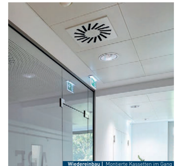
Wiedereinbau | Montierte Kassetten im Gang
