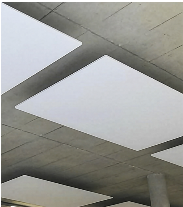
Schallabsorptionsgrad \alpha_s in Oktavschritten nach DIN EN ISO 354 Dicke von 40 mm
