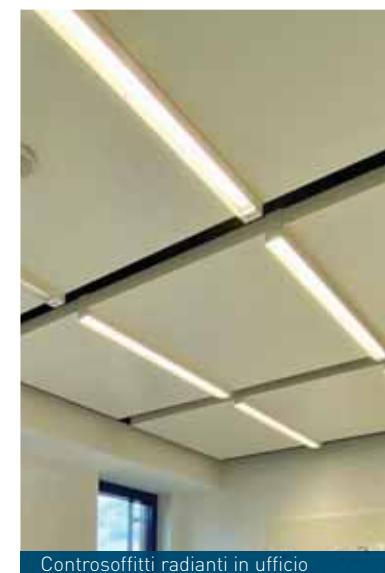
Controsoffitti radianti in ufficio
