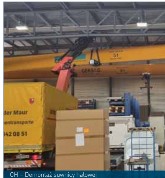
CH - Demontaż suwnicy halowej
