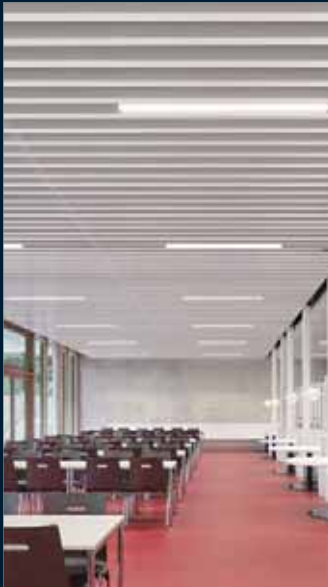
Baffle zapewniają doskonałą akustykę i chłodzenie.
