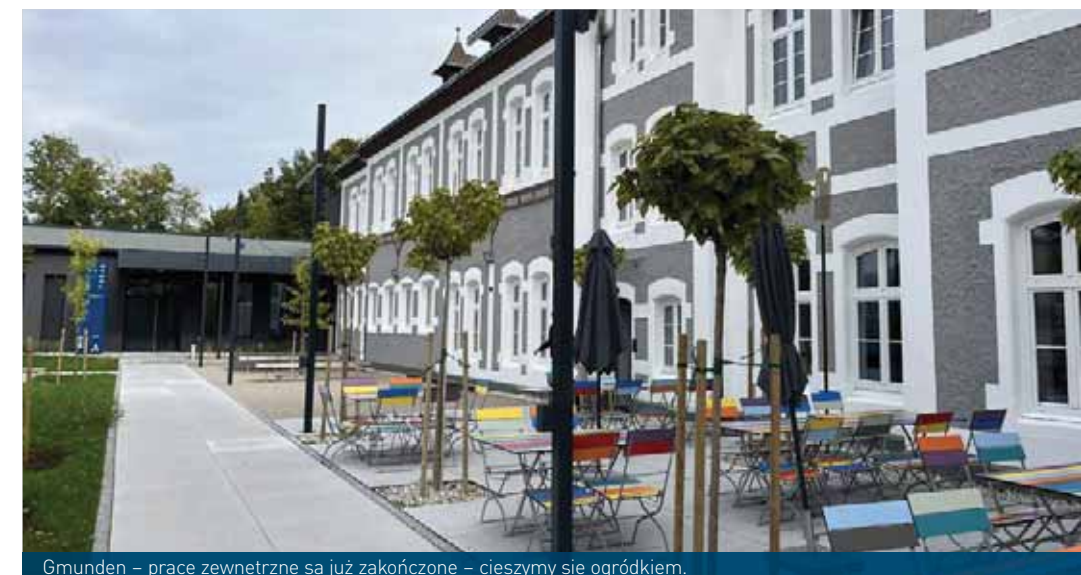
Gmunden – prace zewnętrzne są już zakończone – cieszymy się ogródkiem.
