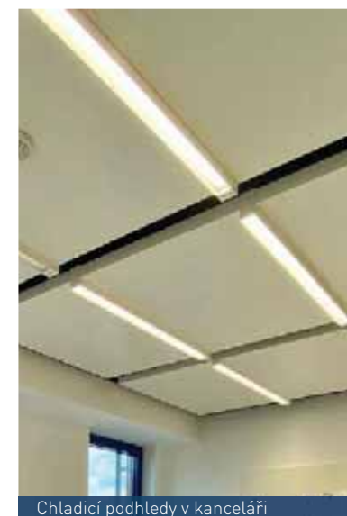
Chladicí podhledy v kanceláři
