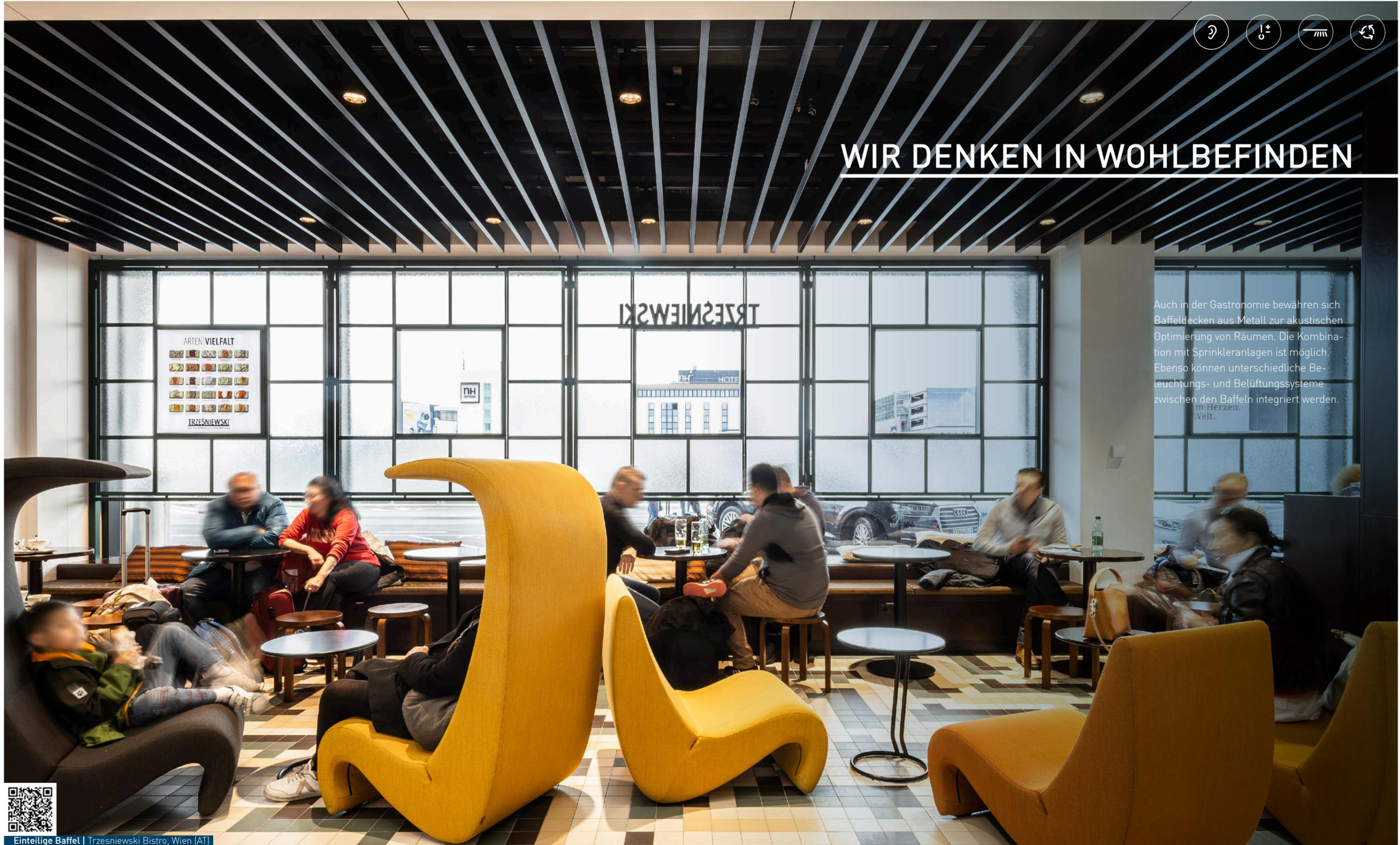
Auch in der Gastronomie bewähren sich Baffeldecken aus Metall zur akustischen Optimierung von Räumen. Die Kombination mit Sprinkleranlagen ist möglich. Ebenso können unterschiedliche Beleuchtungs- und Belüftungssysteme zwischen den Baffeln integriert werden.
