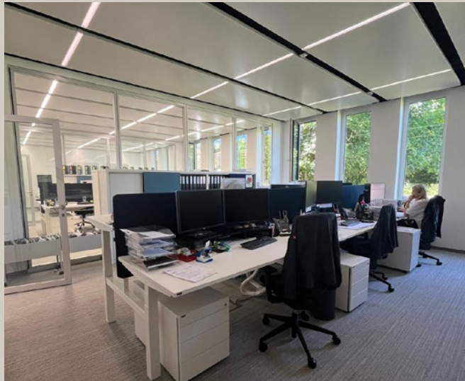
Bürodecken gekühlt mit ALP, Bürotrennwände Re-Use von Viag Intercom
