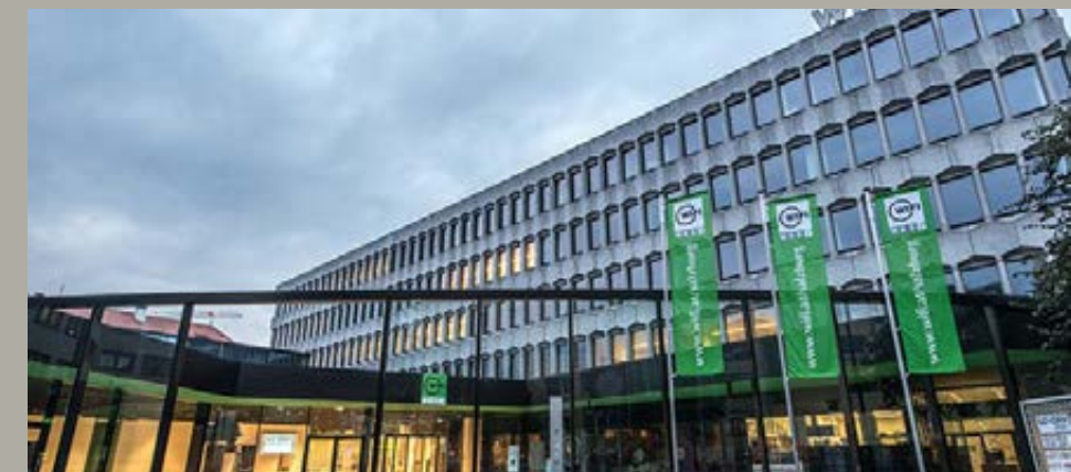
→ Wifi Salzburg, AT chladicí podhledy
