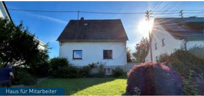
Haus für Mitarbeiter
