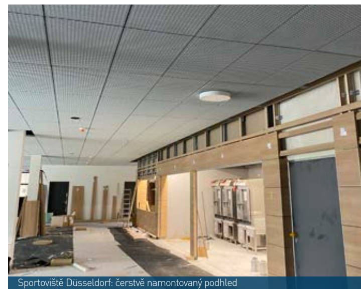
Sportovní hala: montáž podhledu odolného nárazům míče
