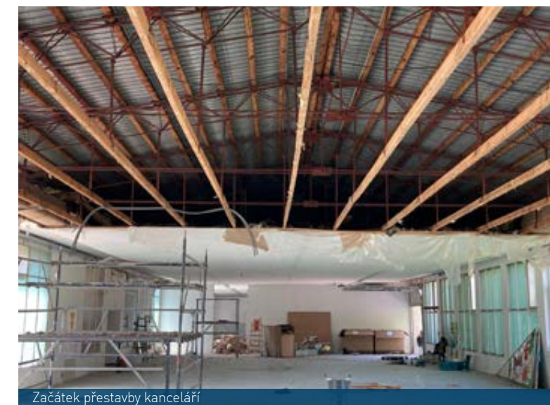
Začátek přestavby kanceláří
