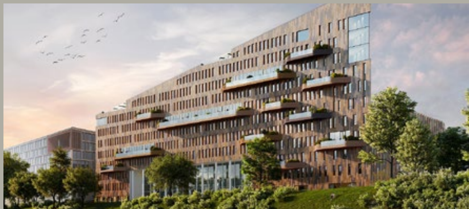
→ Danube House Praga, CZ żagle sufitowe
