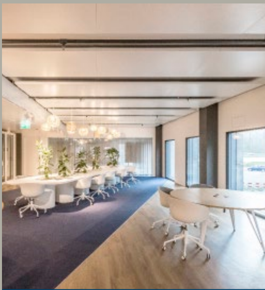
Wieloczęściowe żagle sufitowe w budynku R2 Tower
