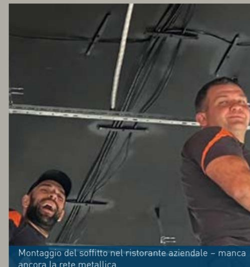
Montaggio del soffitto nel ristorante aziendale - manca ancora la rete metallica.
