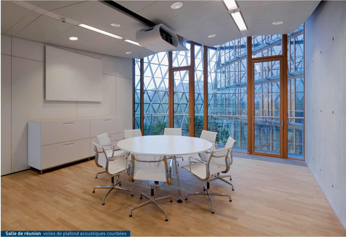
Salle de réunion voiles de plafond acoustiques courbées
