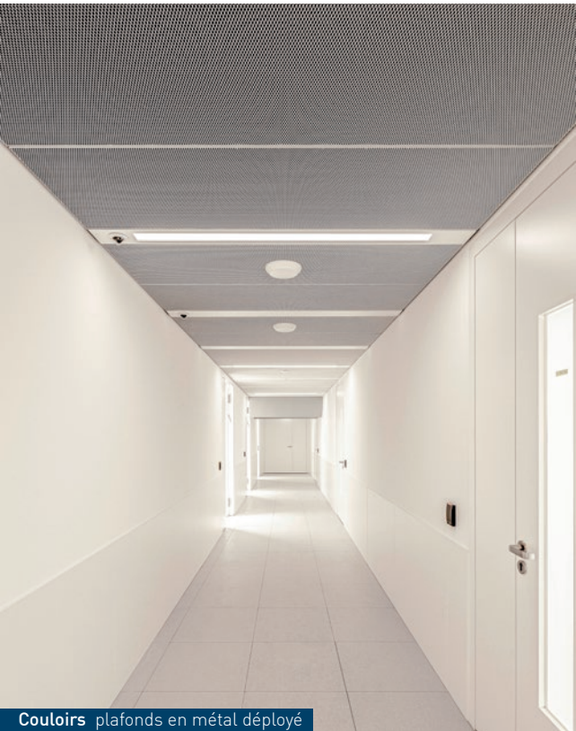
Couloirs plafonds en métal déployé
