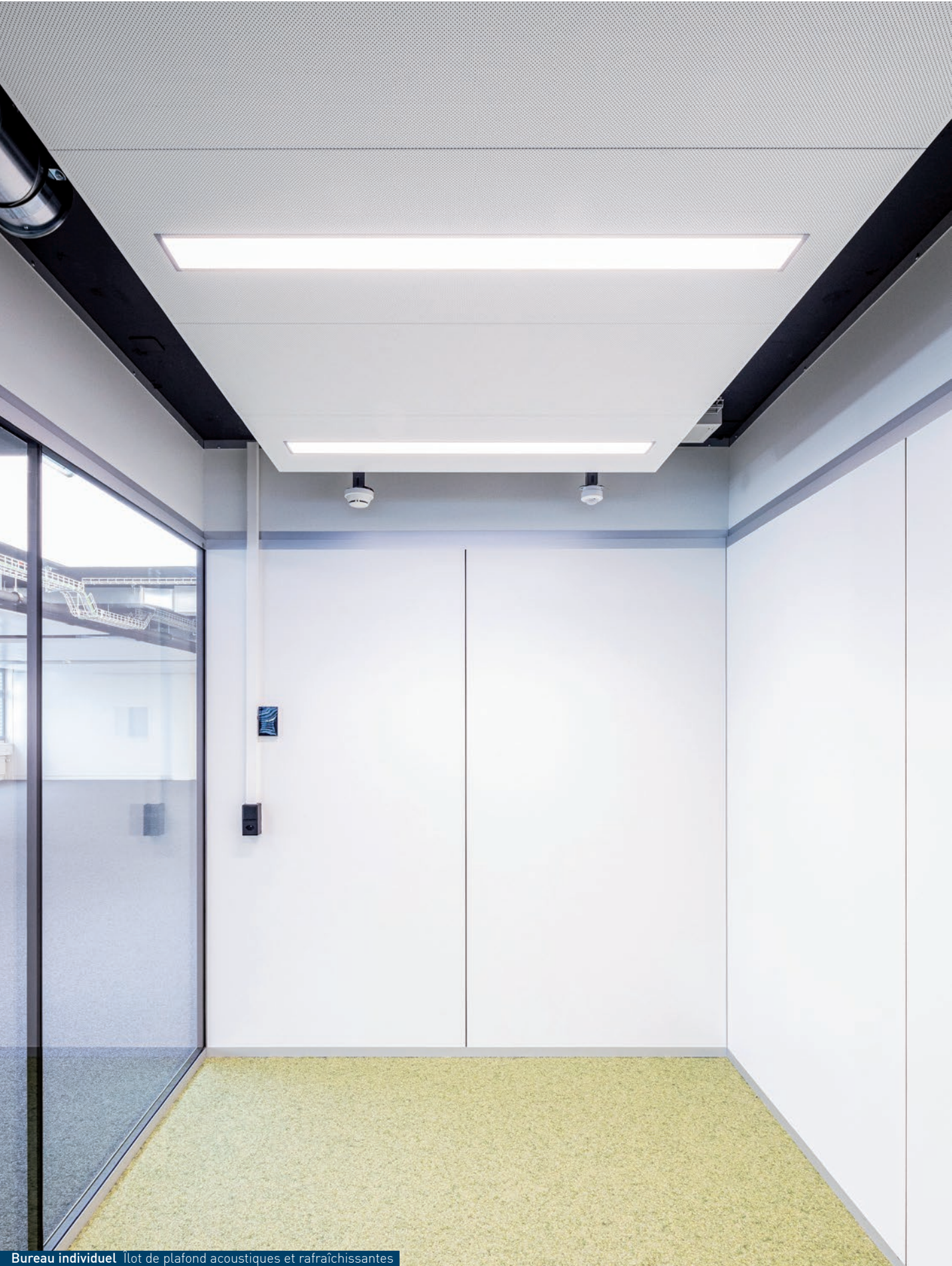
Bureau individuel Îlot de plafond acoustiques et rafraîchissantes
