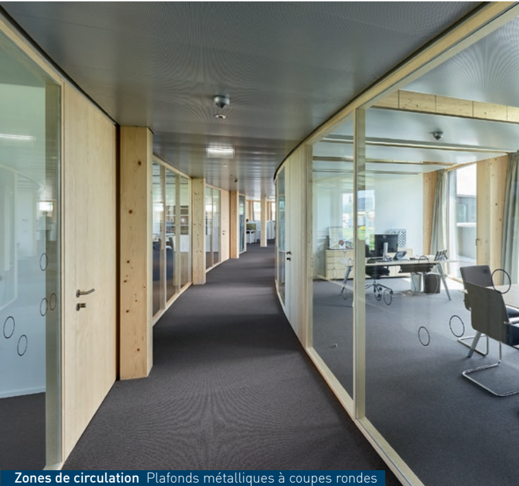
Zones de circulation Plafonds métalliques à coupes rondes
