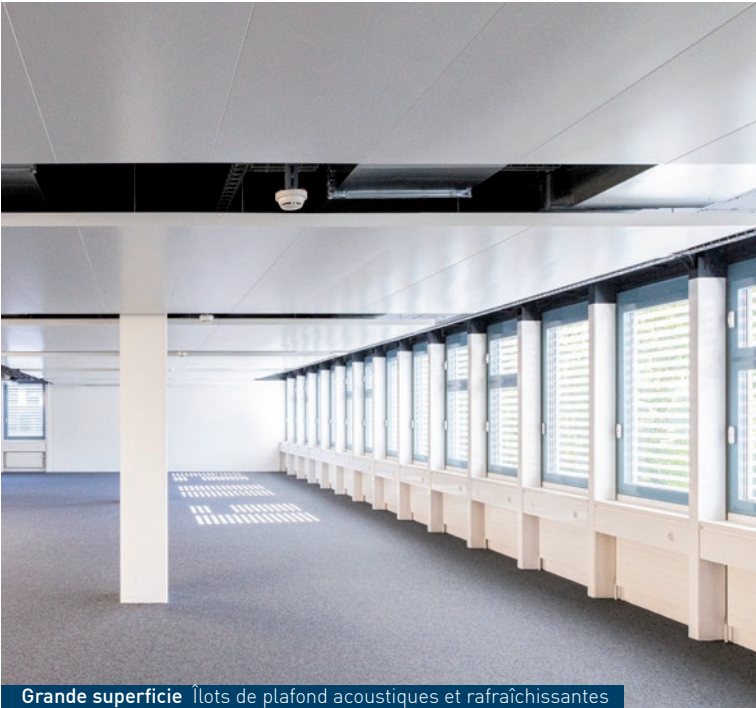
Grande superficie Îlots de plafond acoustiques et rafraîchissantes
