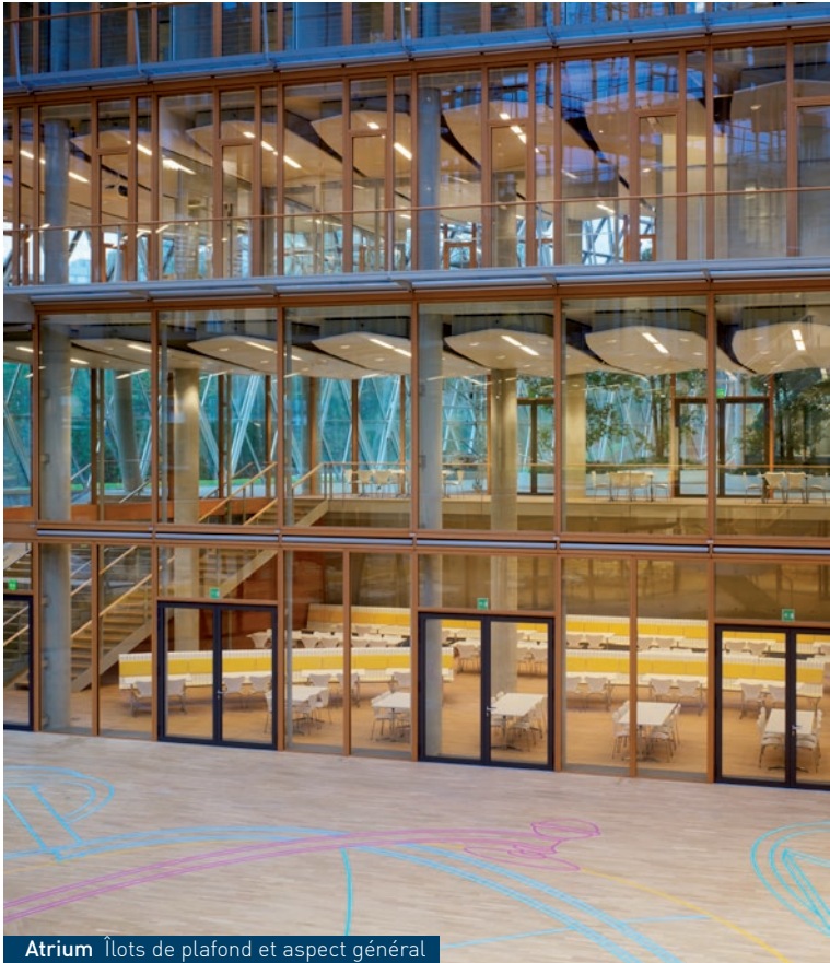
Atrium îlots de plafond et aspect général
