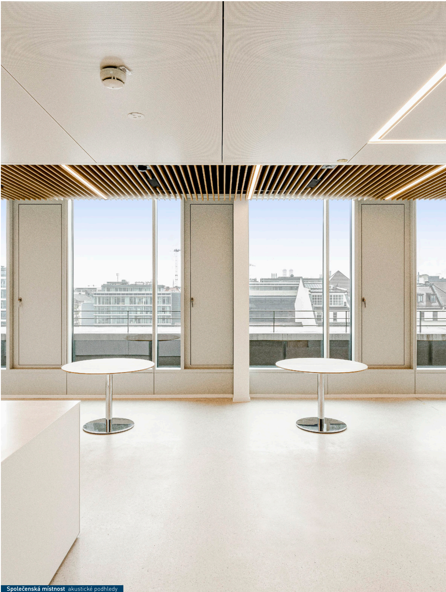
Společenská místnost akustické podhledy
