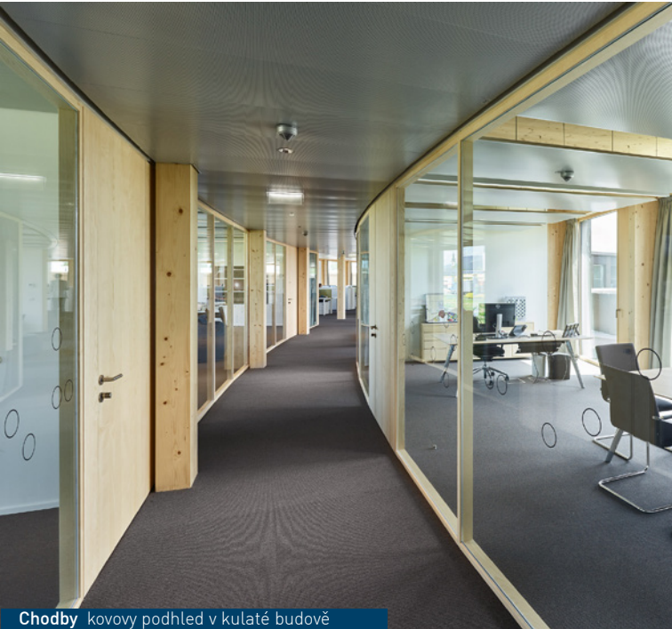
Chodby kovový podhled v kulaté budově
