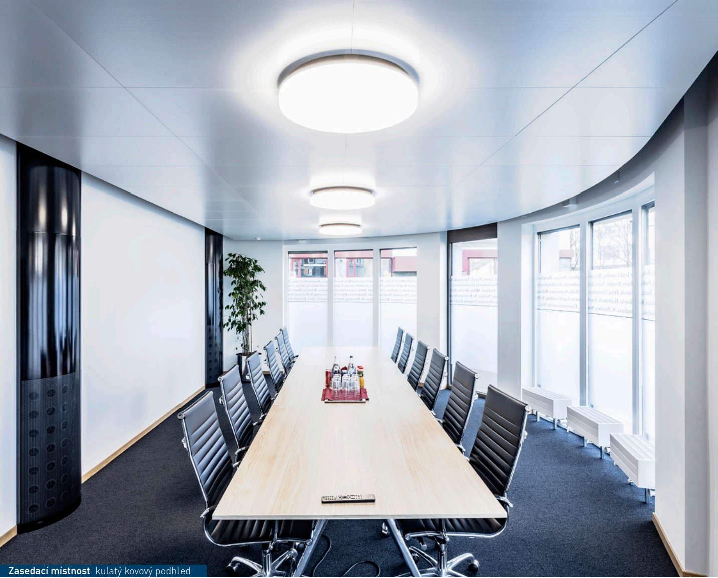
Zasedací místnost kulatý kovový podhled
