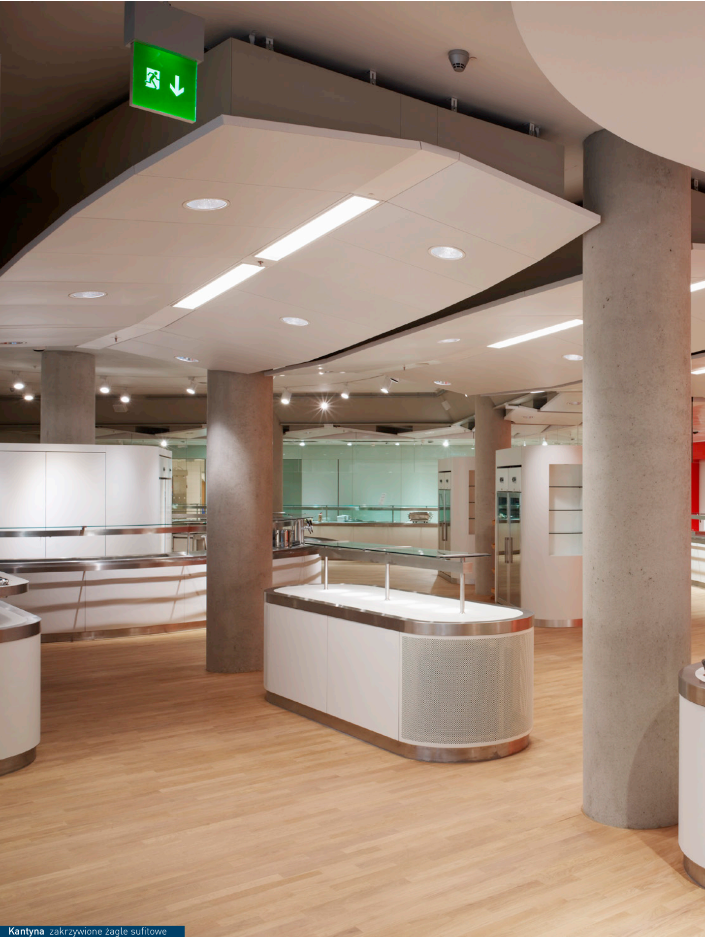
Kantyna zakrzywione żagle sufitowe
