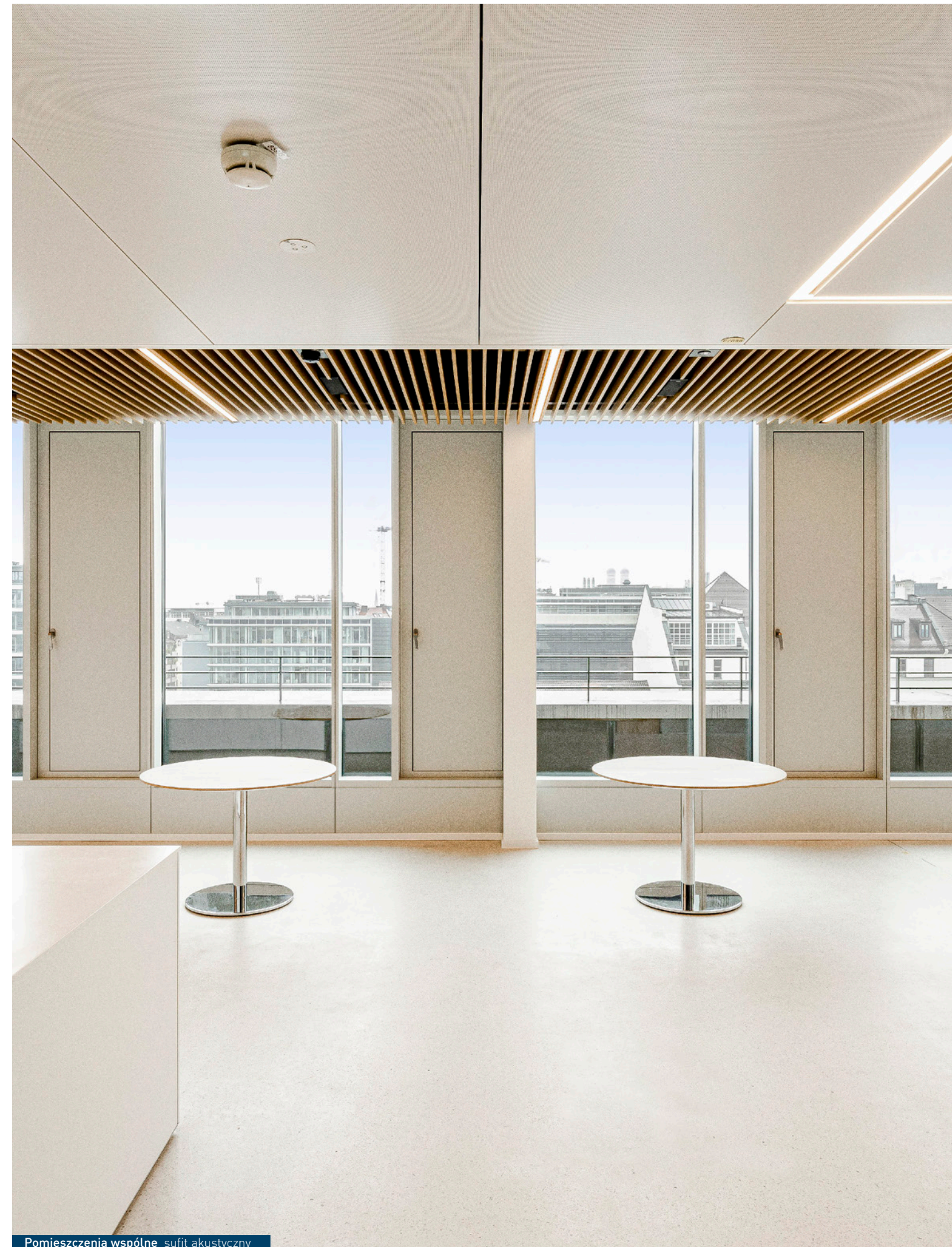
Pomieszczenia wspólne sufit akustyczny
