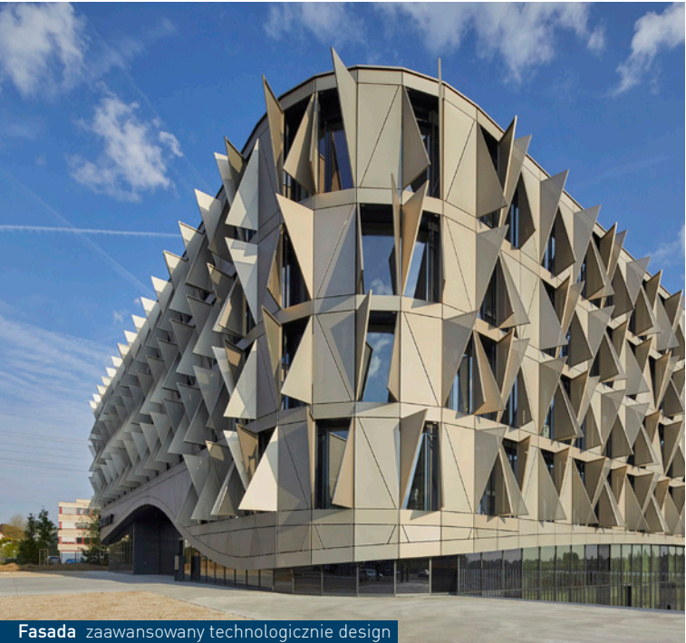
Fasada zaawansowany technologicznie design
