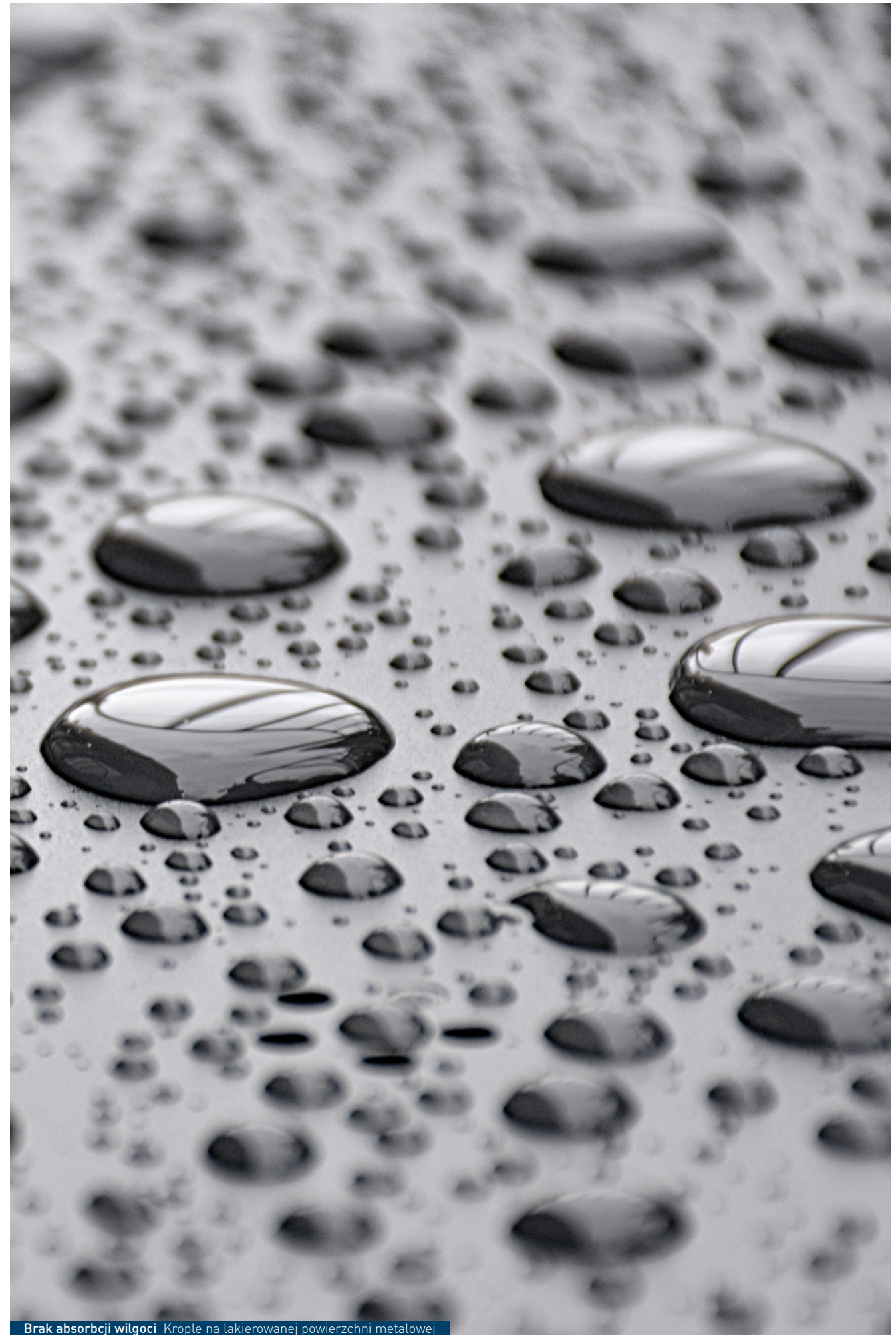
Brak absorbcji wilgoci Krople na lakierowanej powierzchni metalowej
