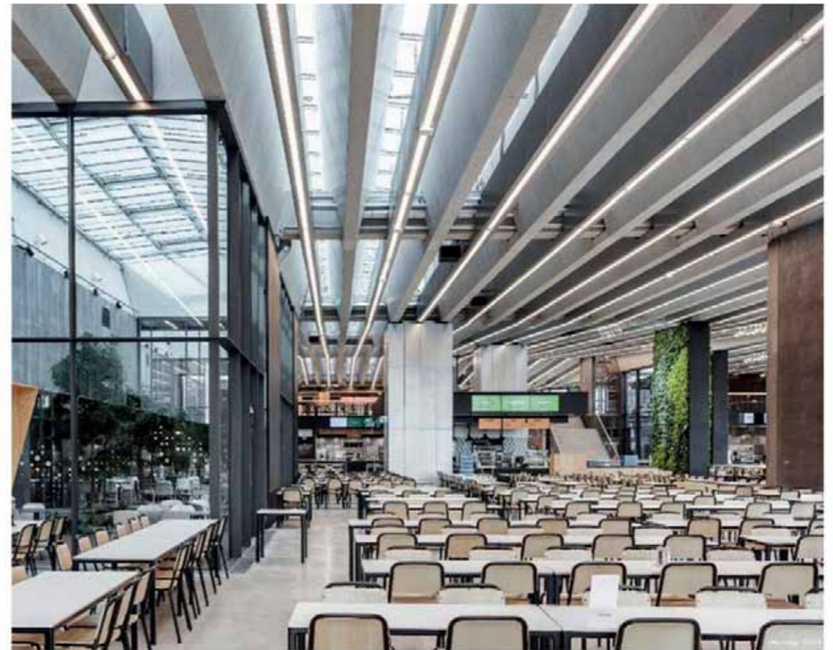
Ein Sportartikelhersteller in Herzogenaurach entschied sich mit den Metallbaffeln für eine ganz besondere Deckenkonstruktion. Bildquelle: Rasmus Hjortshøj – COAST
