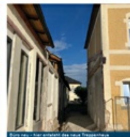
Büro neu – hier entsteht das neue Treppenhaus.
