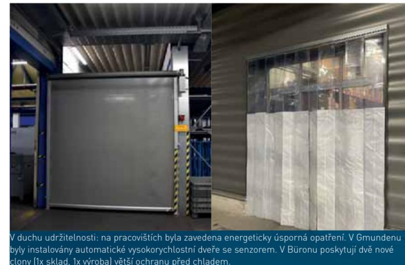
V duchu udržitelnosti: na pracovištích byla zavedena energeticky úsporná opatření. V Gmundenu byly instalovány automatické vysokorychlostní dveře se senzorem. V Büronu poskytují dvě nové clony (1x sklad, 1x výroba) větší ochranu před chladem.
