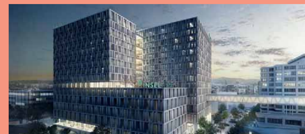
→ Health CH Inselspital Bern Controsoffitti ad isole
