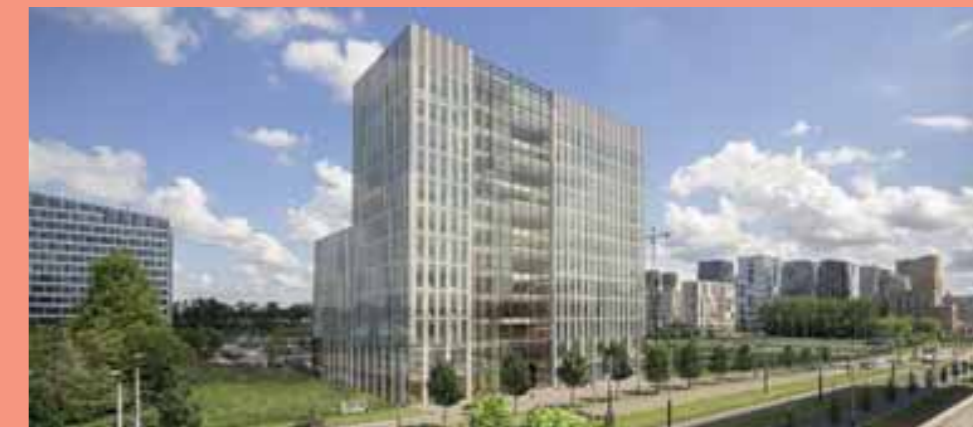
→ Education NLD Onderzoeksgebouw VU De Boelelaan Controsoffitti radianti
