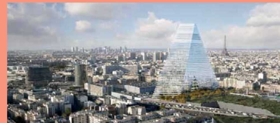
→ Office FR Tour Triangle Parigi Controsoffitto radiante
