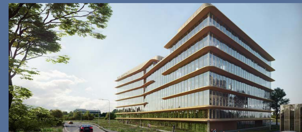
→ Office NL Galapagos Oegstgeest akustický pohled/F0
