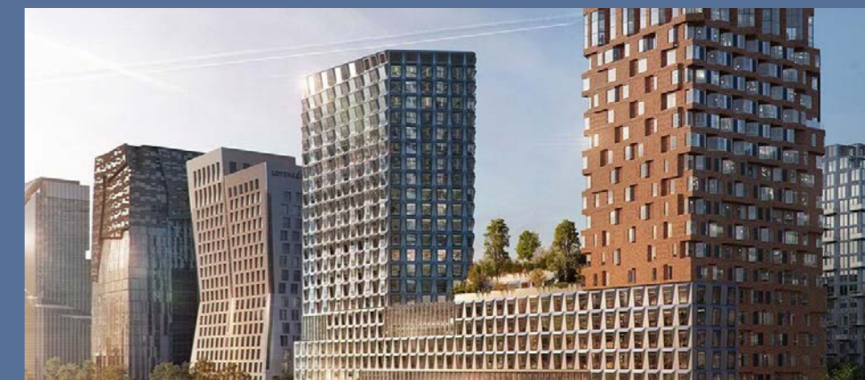
→ Office NL Depuls Amsterdam stropní ostrůvky
